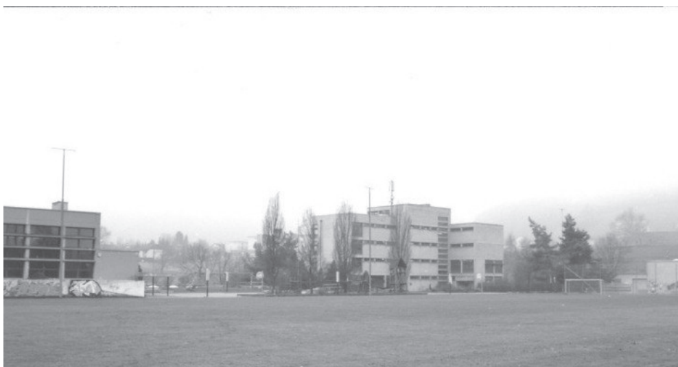
Abb. 5: Bauinventar Kanton Bern; Schulanlage Selhofen (be.ch)
